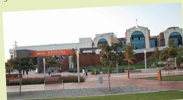
Vista general de l'Hospital Sant Joan de Déu
